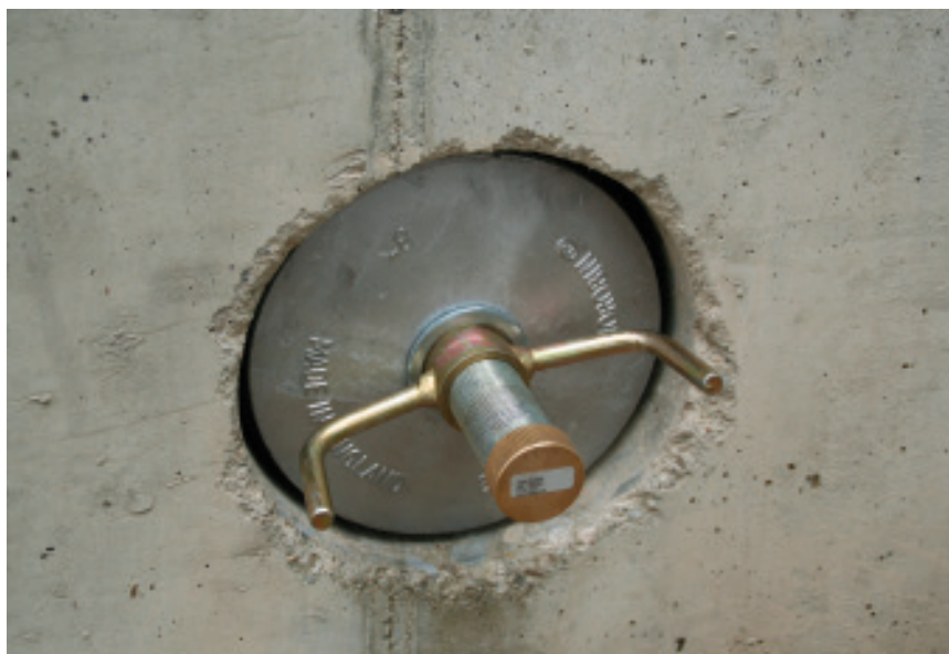
Aqua Stopper comme fermeture d'un forage carotté
