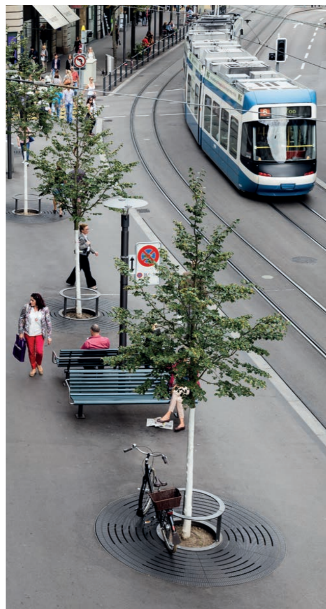
La Bahnhofstrasse de Zurich une fois les travaux effectués. Les grilles d'arbre en fonte ont été réalisées dans le design spécial que souhaitait la ville de Zurich.
