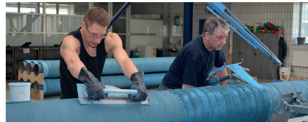
Comme on peut facilement le voir, l'application du mortier de fibro-ciment (FZM) demande un grand doigté. On fait aussi attention au bandage qui stabilise le mortier de ciment et, en cas de tronçonnage du tuyau, facilite son détachement sur la profondeur d'emboîtement du manchon.
