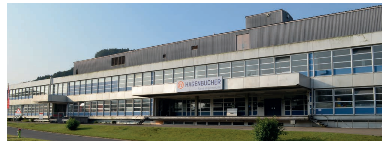
Nos infrastructures pour la production, le stock, l'atelier de soudage, le développement et la formation dans le centre de compétences d'Eglisau.
