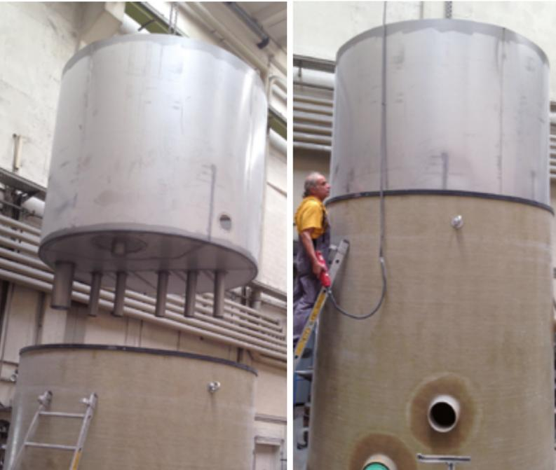
Das Hauptrohr besteht aus einem gewickelten, glasfaser-verstärkten Kunststoffrohr (GFK). Dank der grossen Wandstärke (25-40 mm) wird eine sehr hohe Rohrsteifigkeit erreicht.
